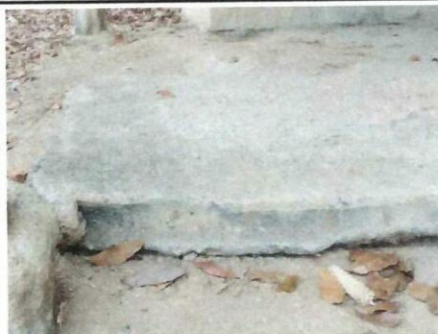
Foto 5: Sustitución de piso de madera por torta de concreto
