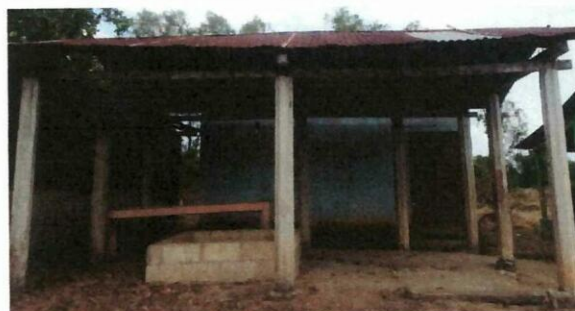
Foto 6: Reparación de paredes
