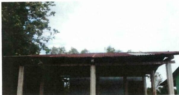
Foto1: Sustitución de lámina, por lámina troquelada Calibre 26
