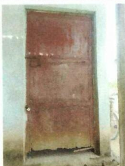
Foto 3: Sustitución de puerta de madera, por metal
